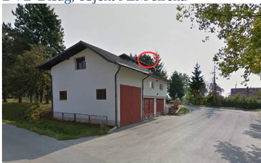
EM sirena se lokalno uključuje (nije upravljiva iz ŽC112)
